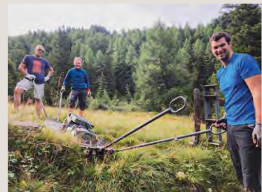
Kraftwerk-Generator Abtransport zur Reparatur ein Knochenjob (Hubert, Mario, Stefan, Martin)
